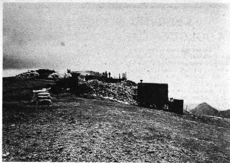
Pogled na gradbišče na Kredarici v lanskem letu (Foto F. Sluga)
