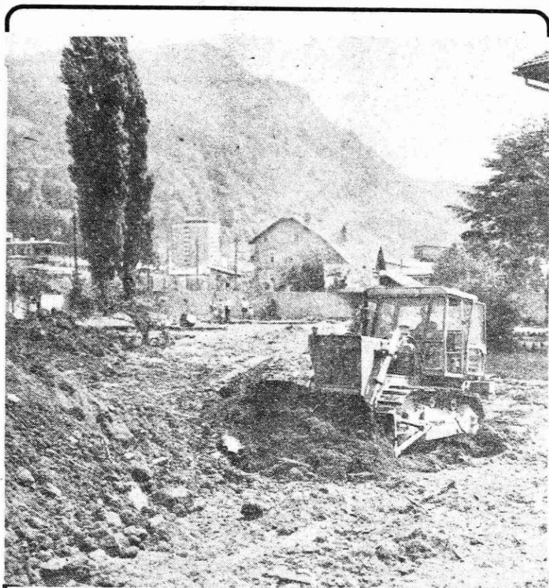
Zemeljska dela za ureditev novega skladišča žice (Foto I. Kučina)
