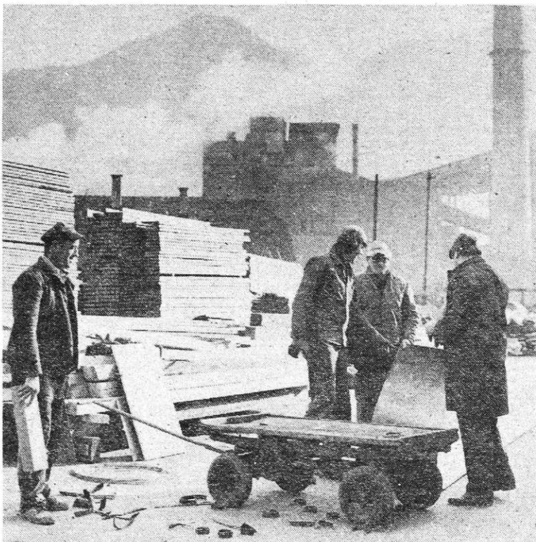
Sodelavci gradbenega oddelka (Foto I. Kučina)
