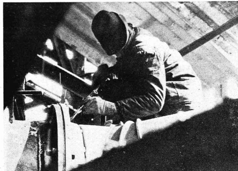
Montaža plavža 1 (Foto I. Kučina)
