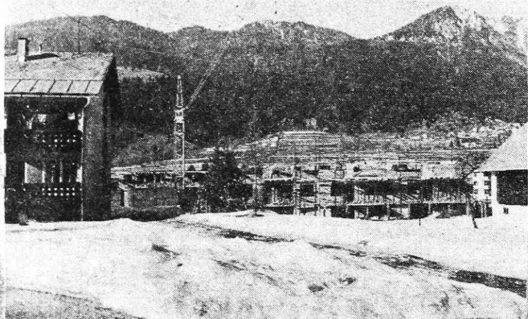
Gradnja blokov v Mojstrani (Foto I. Kučina)
