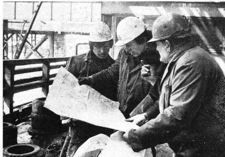
Dela pri remontu plavža 1 za planom (Foto I. Kučina)
