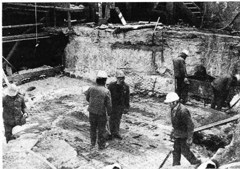
Priprava nosilne plošče za plavž 1 (Foto I. Kučina)
