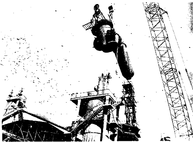
Demontaža plavža 1 (Foto I. Kučina)
