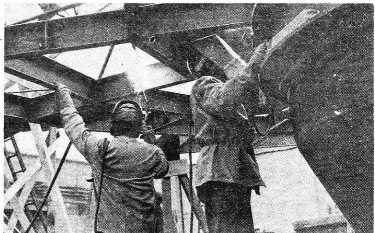
Priprave za remont plavža 1, ki se bo pričel v ponedeljek 1. marca (Foto I. Kučina)
