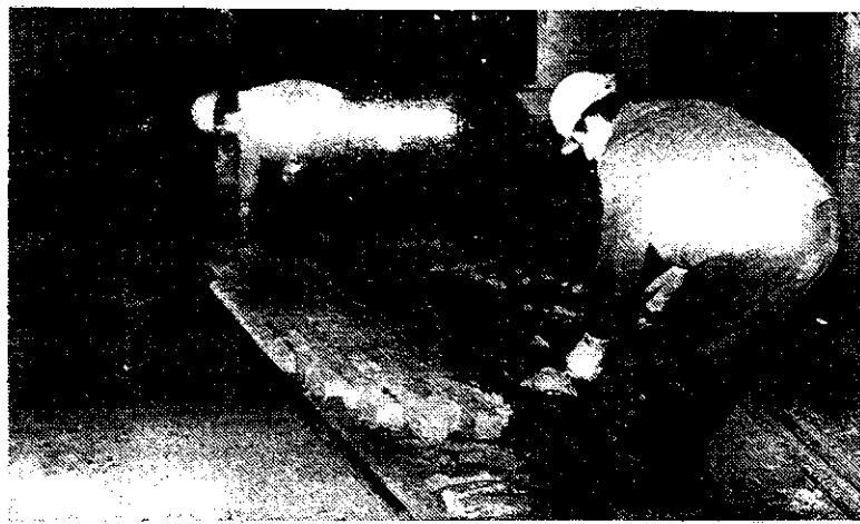
Tudi tako je delo industrijskih zidarjev (Foto I. Kučina)
