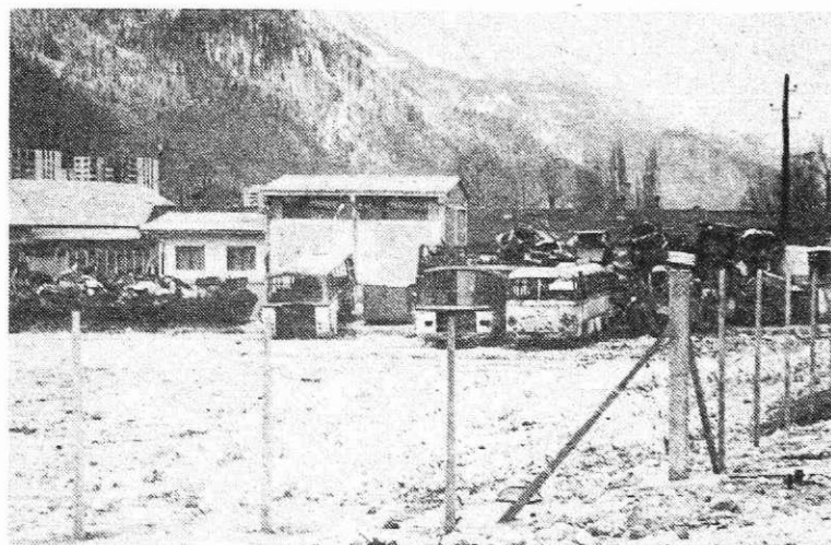
Dinos se je preselil na novo lokacijo zahodno od kurilnice (Foto B. Blenkuš)
