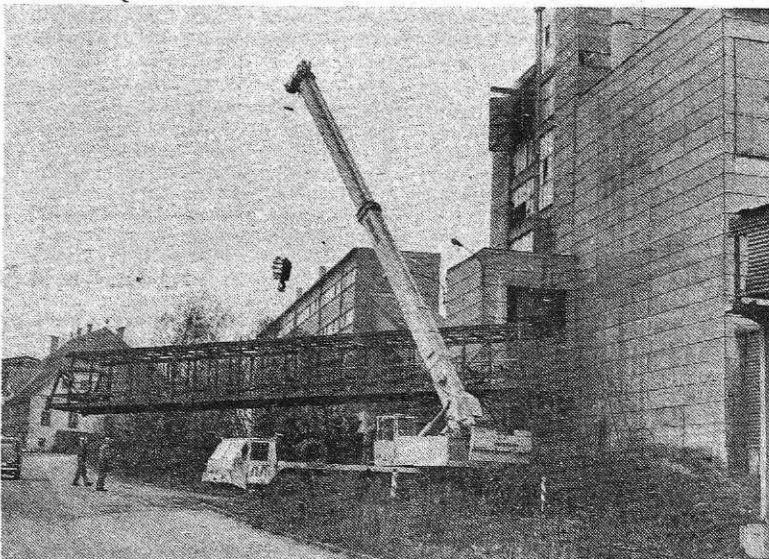
Menjava transportnega traku v aglomeraciji (Foto I. Kučina)
