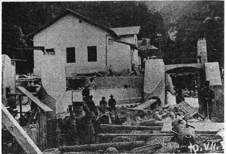
Gradnja jezu za HE Zasip leta 1931 (Foto Rudolf Arh)
