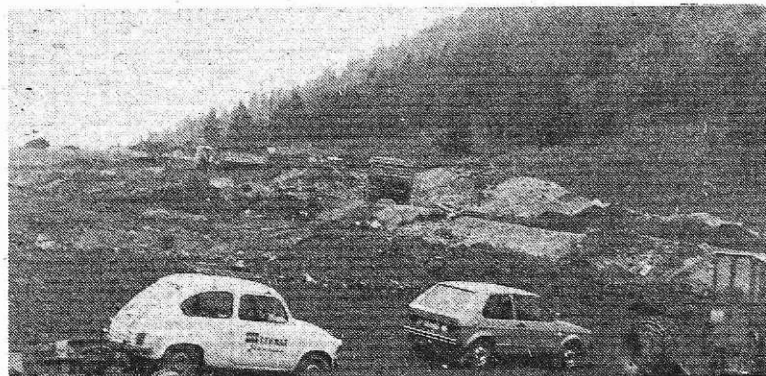
Priprave na stanovanjsko gradnjo na Belem polju pri Hrušici (Foto J. Račič)
