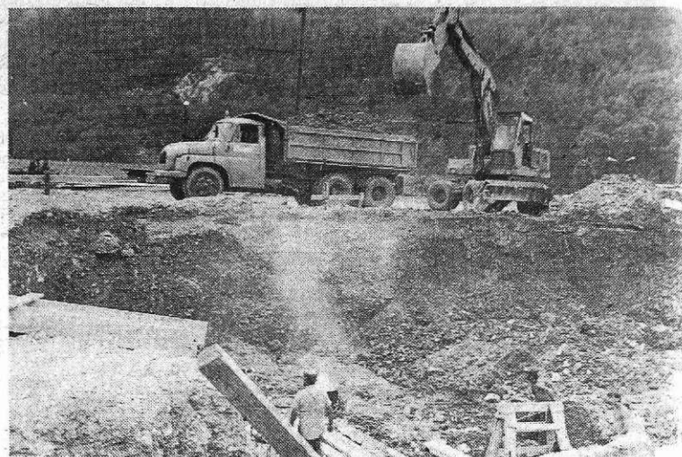
Zemeljska dela za novo parno centralo na Beli (Foto S. Kokalj)
