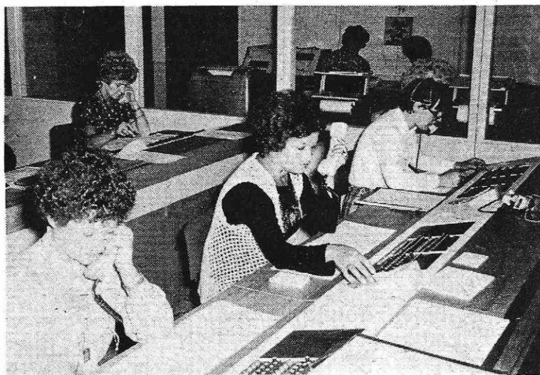
Sodelavke prvi dan v novi avtomatski telefonski centrali (Foto S. Kokač)
