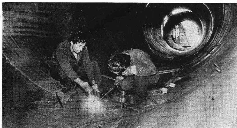
Montaža odpraševalne naprave (Foto I. Kučina)
