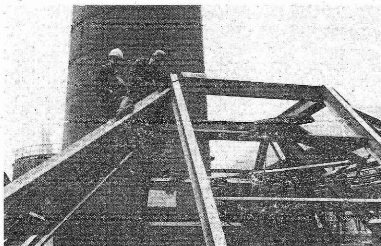
Izdelava gradiva za sesalno napo na ASEA električni peči (Foto S. Kokalj)
