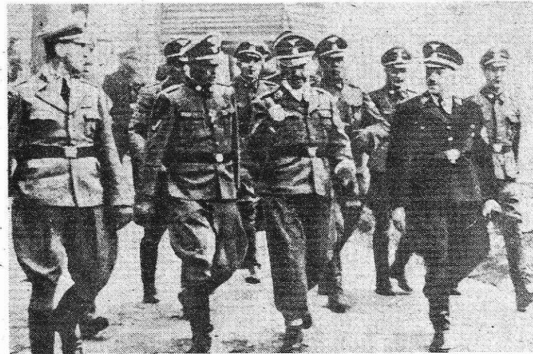
Najvišji predstavniki SS in gestapa pri nadzoru gradnje taborišča
