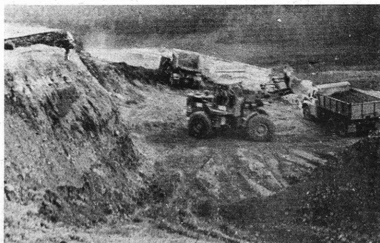
Zemeljska dela pred bodočim karavanškim predorom (Foto B. Blenkuš)
