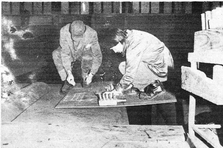
Sodelavca pri signiranju debele pločevine (Foto I. Kučina)
