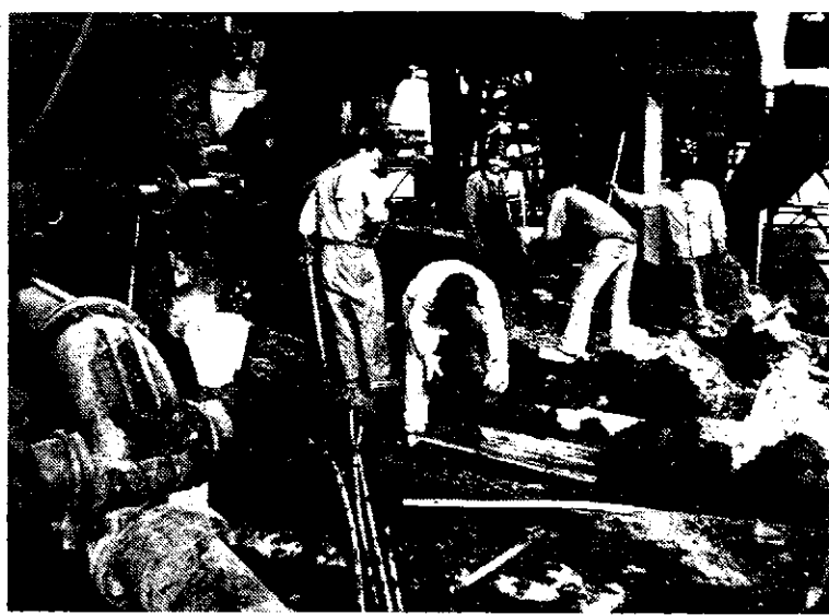
Obzidava livnega žleba pred izlivom grodja iz plavža 2 (Foto I. Kučina)
