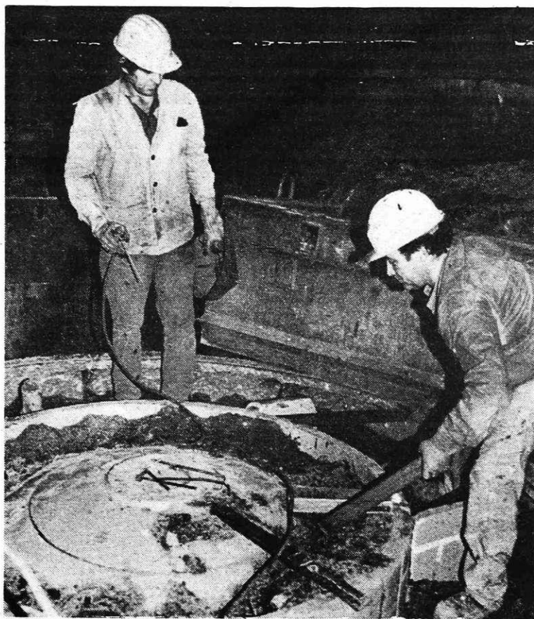
Priprave kalupa za vlivanje ponvice (Foto I. Kučina)
