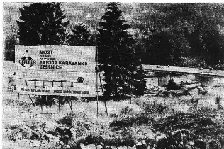
Gradnja mostu čez Savo za novo cesto, ki bo speljana skozi Karavanski predor. (Foto V. Hribar)
