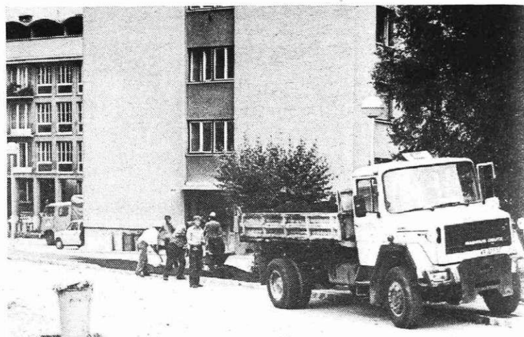
Delavci Cestnega podjetja Kranj te dni dovažajo na Jesenice asfaltno mešanico in z njo ravnaajo slabe, luknjičave in vegaste pločnike. Fini asfalt polagajo tudi na pločnik in na pred kratkim rekonstruirano cesto Cirila Tavčarja na Plavžu, od koder je slika. (Tekst in foto B. Blenkuš)
