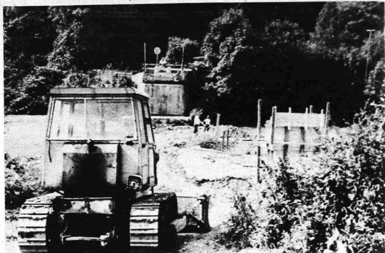
Delavci komunalnega podjetja Kovinar so pred kratkim pričeli graditi nov most čez Savo pri Žvagnu. Tega so zelo veseli prebivalci, ki stanujejo ob vzhodni Mežaklje onstran Save, prav tako prebivalci Plavža, ki so čez ta most hodili na sprehode v naravo. (Tekst in foto B. Blenkuš)
