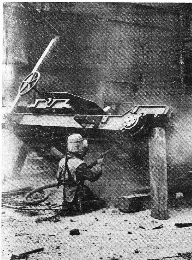
Sodelavec pri peskanju odzemnega voza za koks (Foto I. Kučina)
