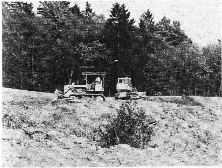
Na pobudo republiškega rudarskega inšpektorja se je začela sanacija glinokopa opuščene opekarne Dvorske vasi. Načelnik za gradbene in komunalne zadeve ter varstvo okolja občine Radovljica je že izdal odločbo o sanaciji glinokopa. Po sanaciji glinokopa naj bi ta del zasejali s travo, nato pa pogozdili. Vse več govorimo o varstvu našega okolja in tudi to je korak naprej, da prihajamo iz besed k dejanjem. (Tekst in foto: Janez Stroj)
