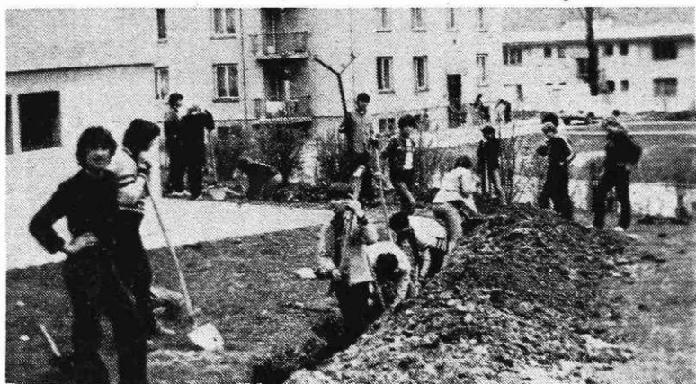
V krajevni skupnosti Javornik-Koroška Bela se nadaljuje lokalna mladinska delovna akcija — izkop jarka za telefonski kabel. V soboto, 19. aprila, je na tej akciji sodelovalo 61 mladih brigadirjev. Vzrok za slabšo udeležbo kot v prejšnjih sobotah so nedvomno brigadirski dnevi, ki se izvajajo med tednom. Akcija se počasi bliža koncu. (Tekst in foto Vasa Hribar)
