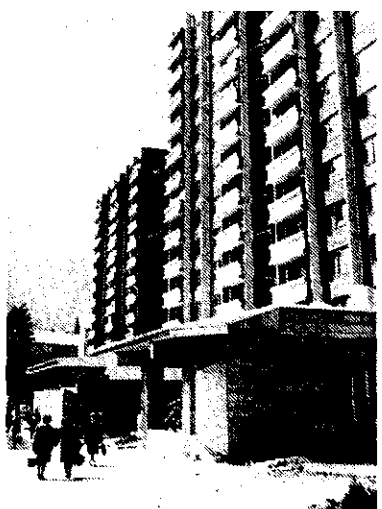
Gradnja poslovnih prostorov v stolpnici na Plavžu (IK)
