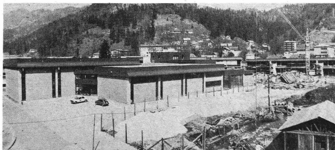
Šolski center na Plavžu, v ozadju gradnja vzgojno-varstvene ustanove
