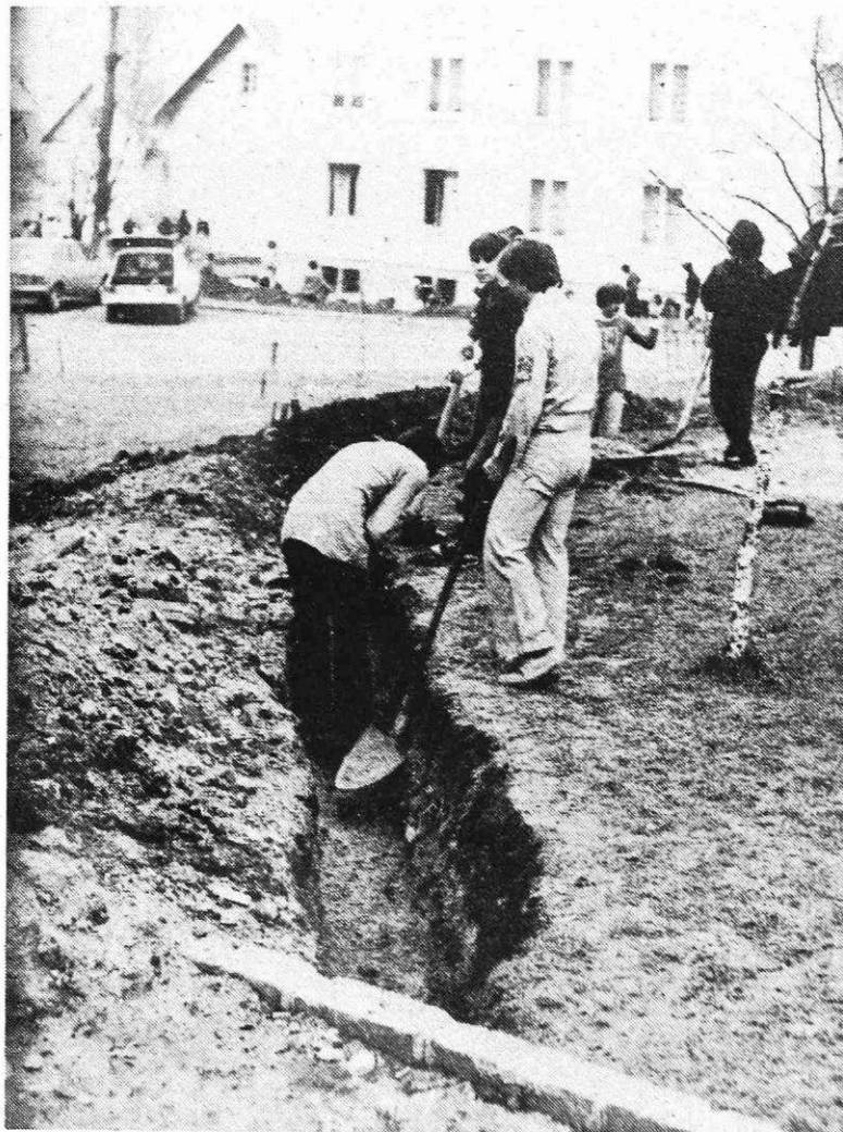
Mladi jeseniški brigadirji pri izkopu jarkov za telefonski kabel na Koroški Beli. (Foto V. Hribar)
