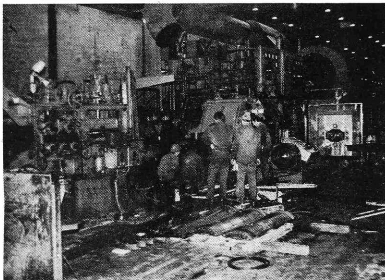
Remont na Sendzimir ogrođju (IK)
