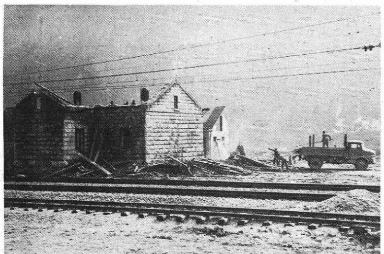
Med rekonstrukcijo železniške postaje na Jesenicah so prejšnjo soboto in nedeljo, 22. in 23. marca, podrli in odstranili staro železniško čuvajnico pred Logom Ivana Krivca, ki je bila zgrajena istočasno s karavanskim predorom. Poslopje je bilo napoti novim tirom, ki bodo tu zaradi hitrejših sestave vlakov speljani preko nove drče. (Tekst in foto B. Blenkuš)
