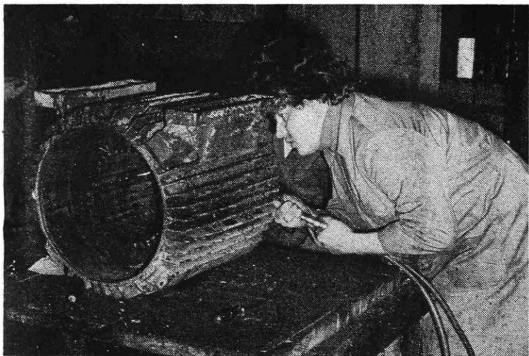
Sodelavka pri čiščenju statorja elektro motorja (SK)
