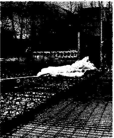
Gradnja računskega centra (SK)
