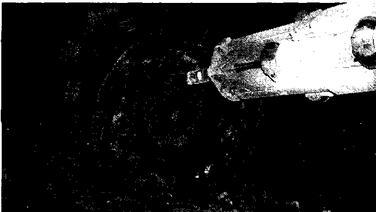
Strojno čiščenje notranjosti glave Kaplanove turbine (SK)
