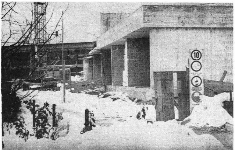
Gradnja druge faze šolskega centra na Plavžu (I. K.)
