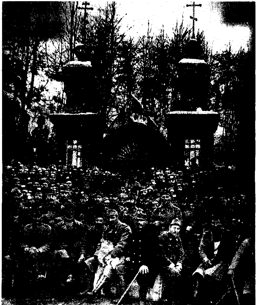
Ruski ujetniki in avstrogrški stražarji v času gradnje ceste na Vršču
