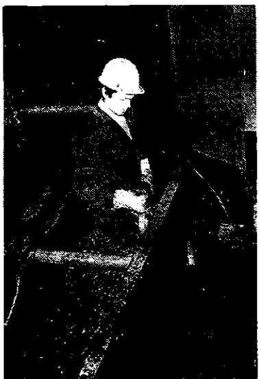
Sodelavec pri remontu v aglomeraciji (SK)
