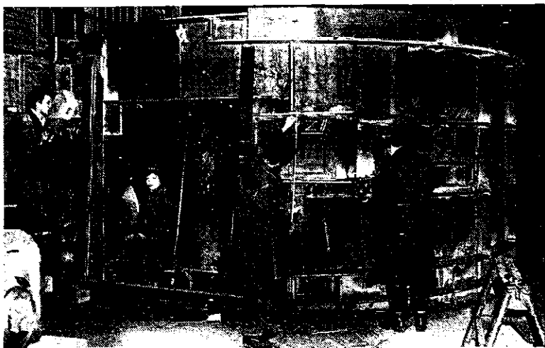
Sodelavci konstrukcijske delavnice pri izdelavi plošče za električno peč (Foto SK)
