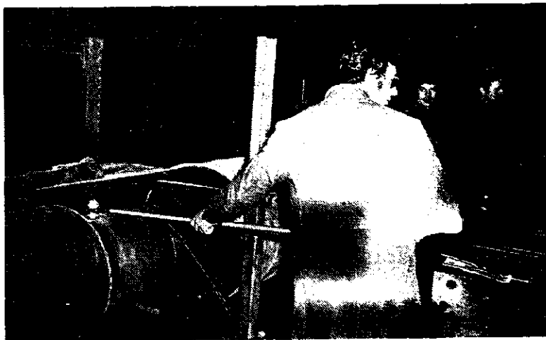
Merjenje temperature vzdržljivosti zavarjenega valja (SK)
