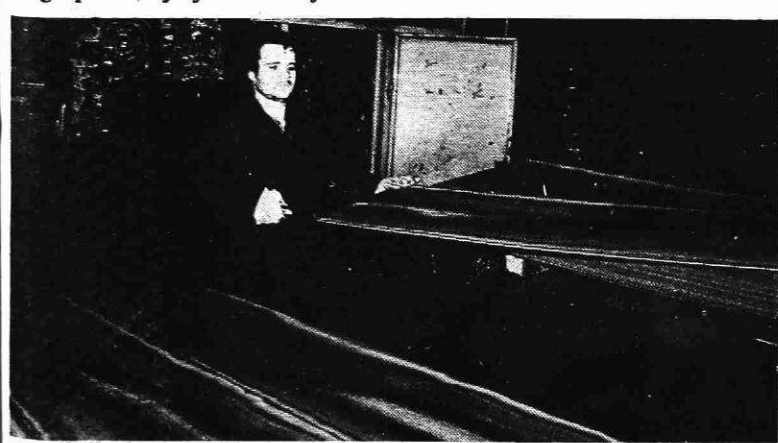
V valjarni na Javorniku (SK)
