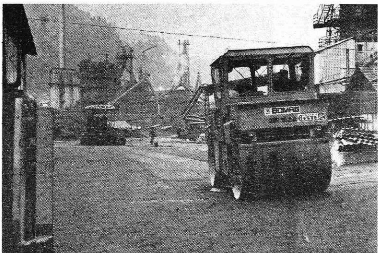
Asfaltiranje cest v Železarni (IK)
