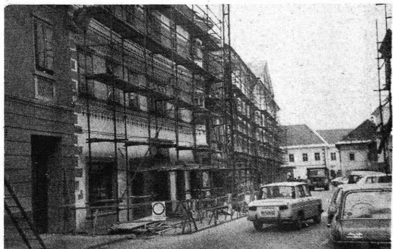
Stari del Radovljice obnavljajo in ga oblikujejo v izvrzno stanje. Doslej so v starem mestnem središču obnovili že večino poslopj na jugozahodni strani, sedaj pa so na vrsti stavbe na severovzhodni strani. Kot vidimo na sliki ta čas obnavljajo staro Vidicovo hišo in graščino (tekst in foto B. Blenkuš)
