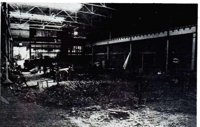
Gradnja novih strojnih delavnic na Javorniku (I. K.)
