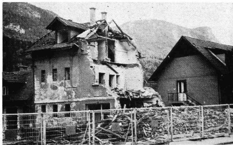
Med podiranjem starih stavb med carinarnico in P-MARKETOM, ki so ta čas že zravnane z zemljo, kjer bodo zgrajene nove stolpnice
