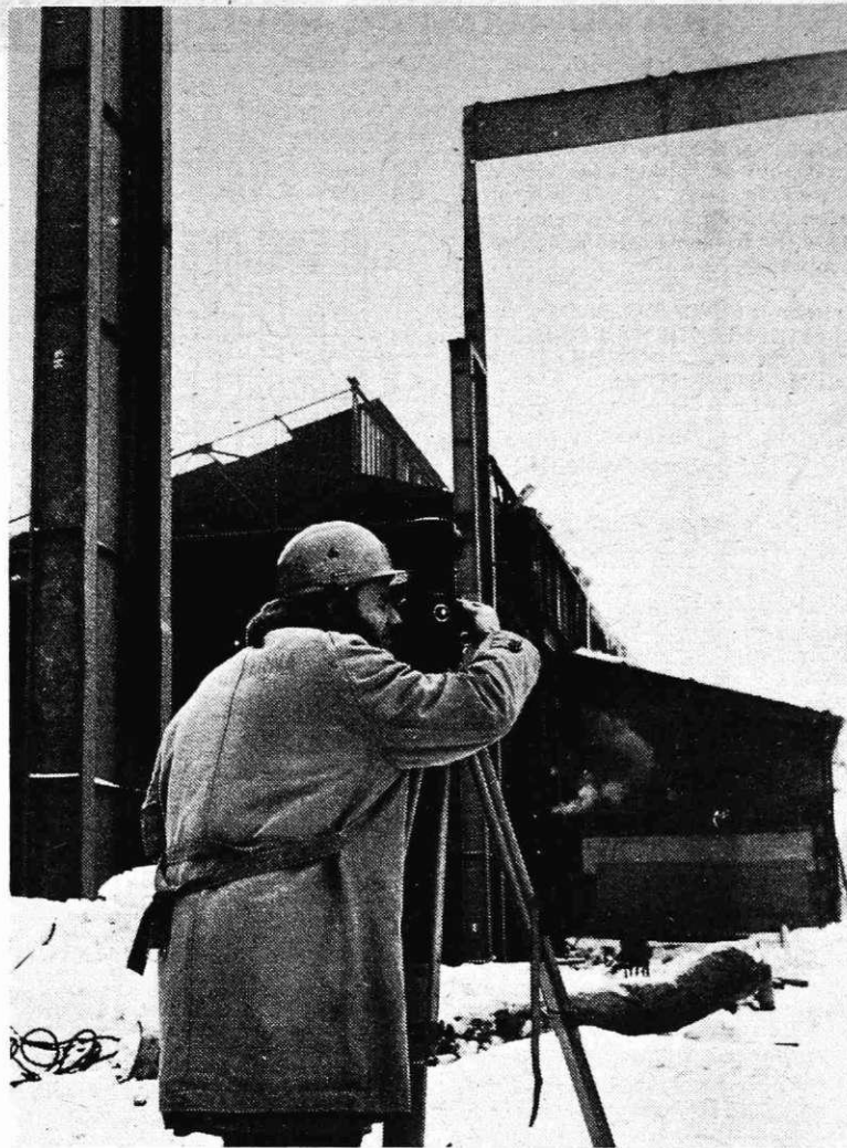
Sodelavec pri centriranju stebrov hale za konti liv
