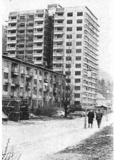
Stolpnica S-1, ki jo delavci SGP Gradbenec gradijo na Plavžu ob stacbi Elektro – Žirovnica. Predvidajo, da bo v njej 21 stanovanj pripravljenih za iselincev do jeseni.
