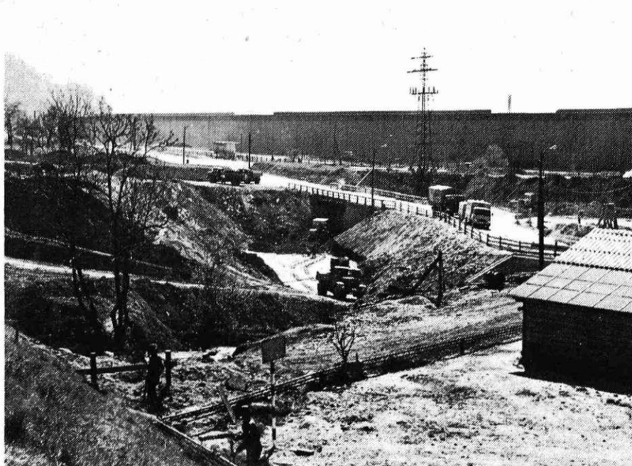
Obsežna dela pri gradnji novega križišča na prestavljeni cesti ob potoku Javornik
