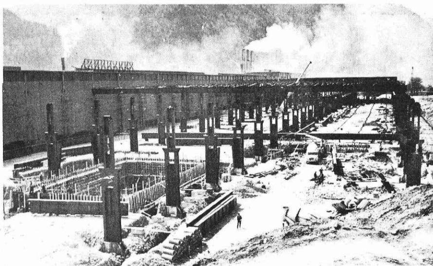
V aprilu 1975 je bil pogled na gradbišče takle
