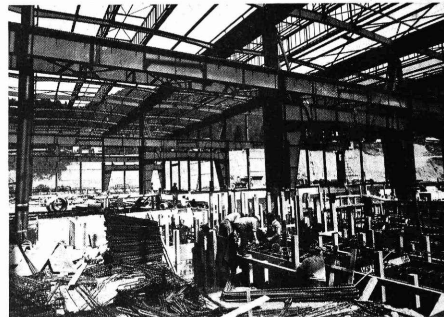
Izdelava temeljev za naprave hladne valjarne
