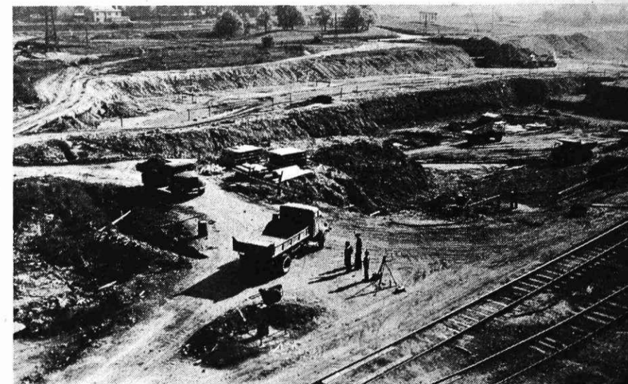
Izkop temeljev za hladno valjarno Bela
