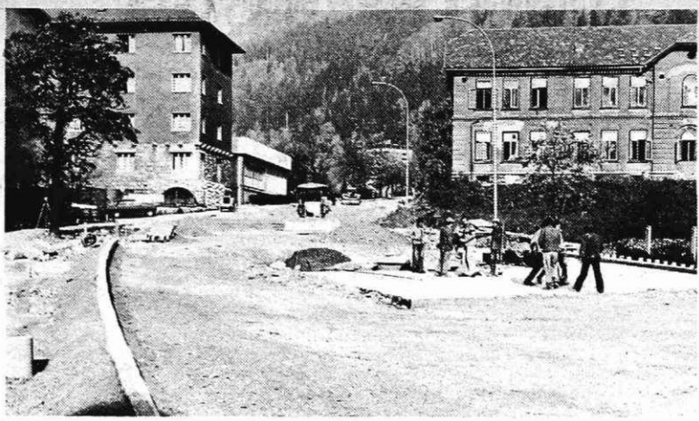
Rekonstrukcija ceste prvega reda od Javornika do doma TVD Partizan se bliža koncu
