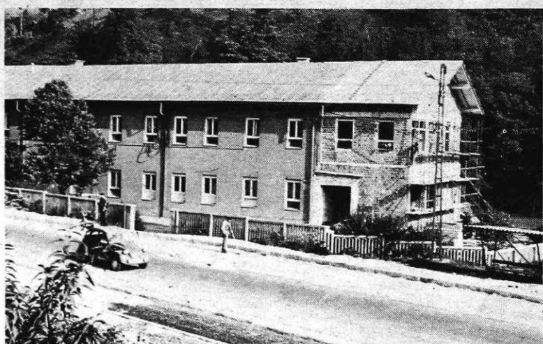
V izgradnji nov prizidek obratne ambulante
