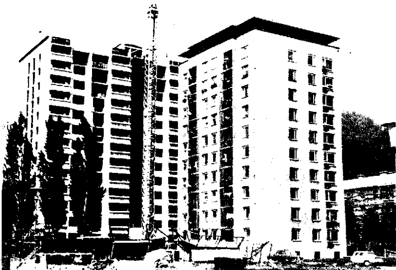
Gradnja druge stolpnice na Titovi cesti dobro napreduje
