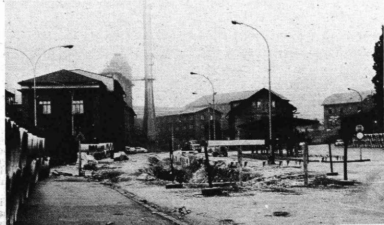
Rekonstrukcija ceste od Javornika do železniškega nadvoza se bliža zadnji tretjini
