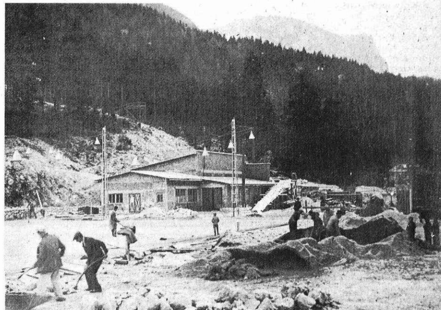
Prva dela pri izgradnji umetnega drsališča
