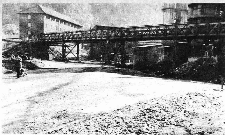
Razširjanje cestišča med aglomeracijo in plavžem in rušenje še preostalih vodnih rak
