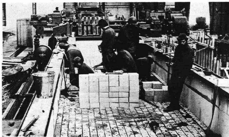
Obzidava lužilnih banj v novi hladni valjarni
