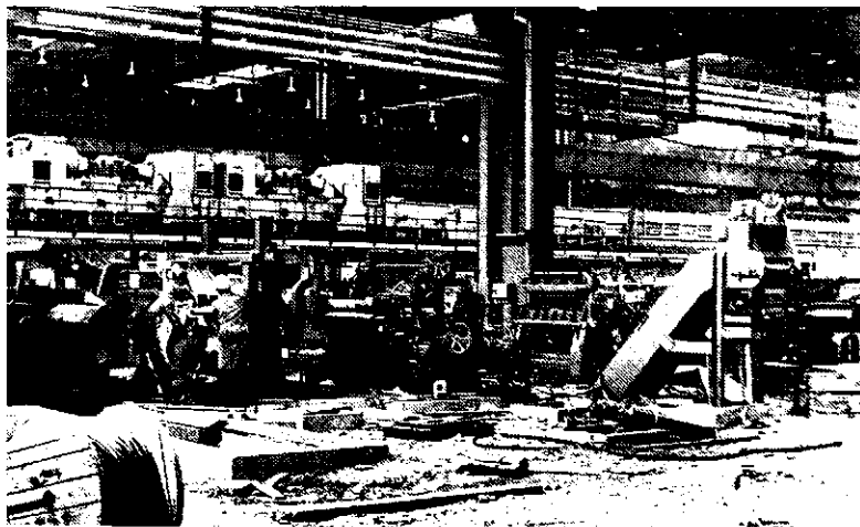
Strojna montaža vzdolžnih škarij za nerjavna jekla
