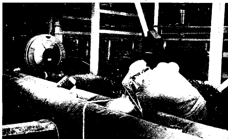
Delavec pri montažnih delih v novi hladni valjarni
