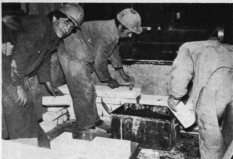
Obzidava peči v novi hladni valjarni
