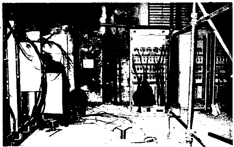
Elektroinstalacijska dela v strojnici Sendzimir ogrodja.
