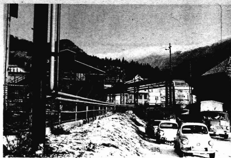
Vhodna cesta v javorniške obrate
